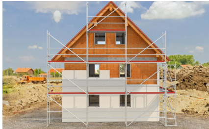
Renovering av byggnader
